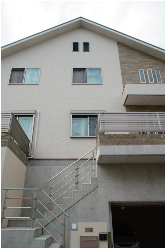
住居下にガレージを設けた“高さ”を感じる堂々とした外観。
