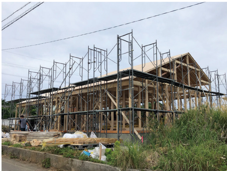
JWOODのLVL構造材（柱・梁・桁） 上棟時の建築現場
