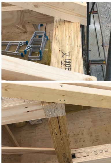
JWOODのLVL構造材（柱・梁・桁） 上棟時の建築現場
