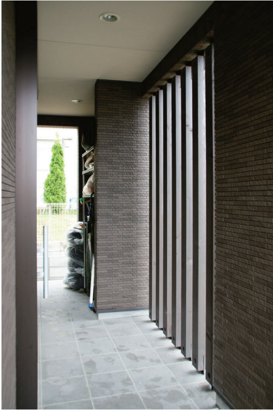
玄関前に設けられた屋外収納スペース。
