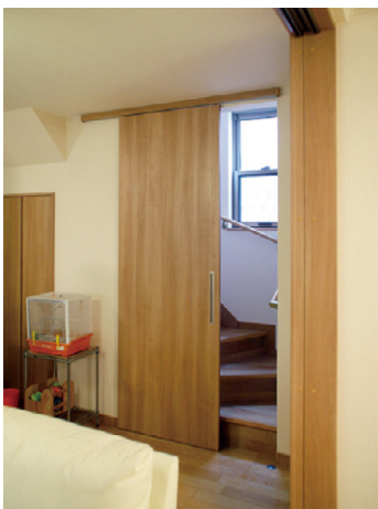
階段に扉を設け、冷暖房効率をアップ。
