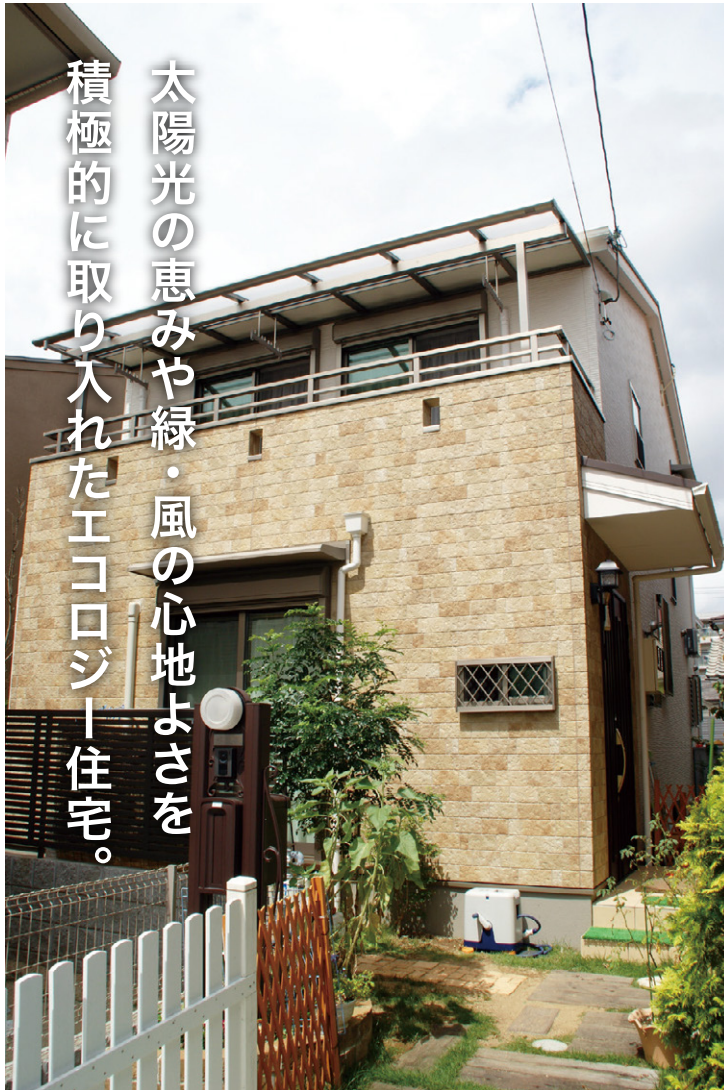
南面に大きなバルコニーを設けたナチュラルなイメージの外観。
