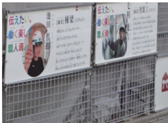
工事中は、道を歩く小学生に向け、職人の仕事とそれに込められた魂を紹介する仮囲いパネルを設置。
