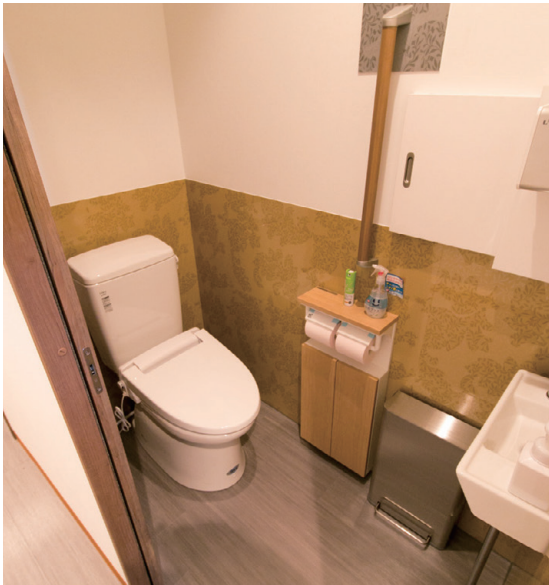
トイレは段差のない引き戸式の出入り口
