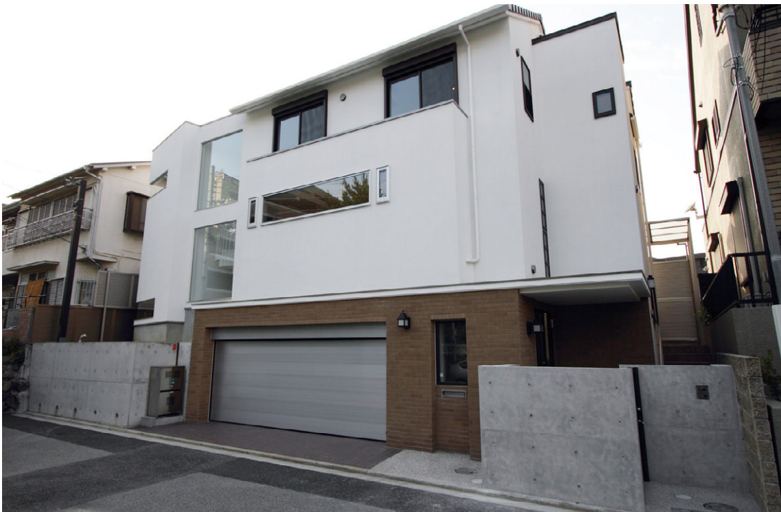
白に塗られモダンな印象を与える外観。らせん階段が見える窓より左が増築部。
