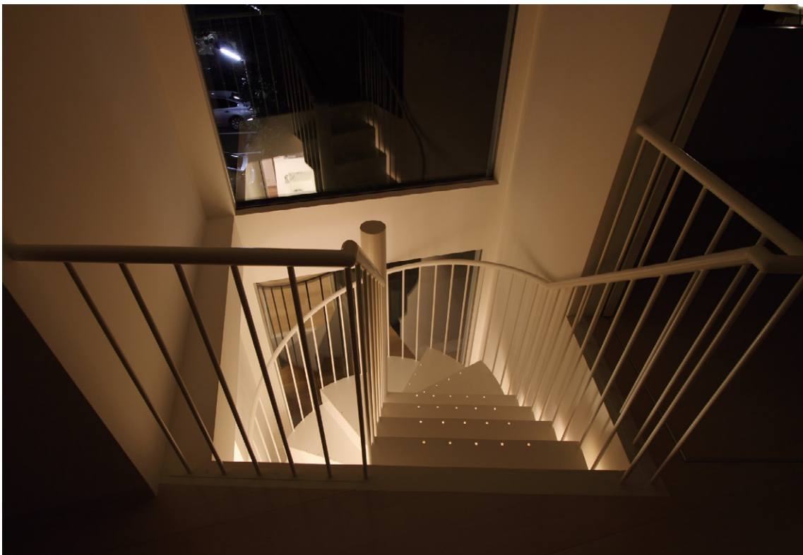
増築部分に設けられたらせん階段。外観上のアクセントにもなっている。
