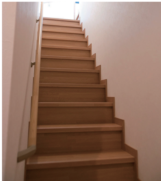
階段もプランを変え新たに設置
