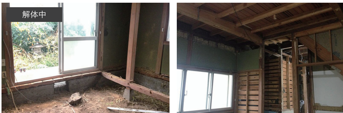
内張りをほとんどはがし基礎や構造を補強
