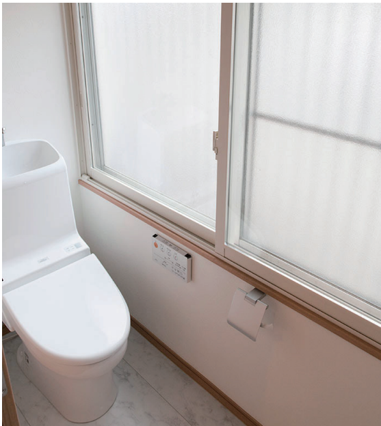
トイレも内窓を設置し断熱性をアップ
