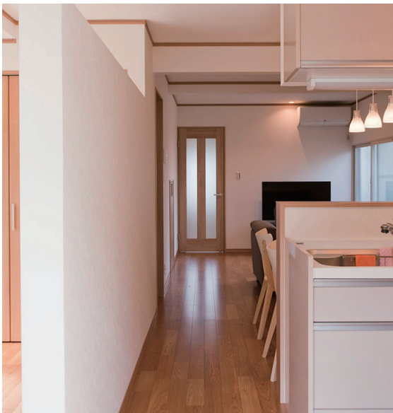
間仕切りも天井部にヌケを作り開放感を確保
