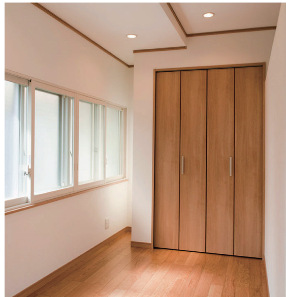
内窓を追加することで2重サッシにして断熱性をアップ
