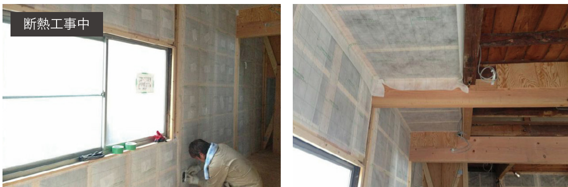
新聞古紙からリサイクルされた環境配慮型断熱材で調湿、防音効果もある「セルローズファイバー」を壁・天井に充填
